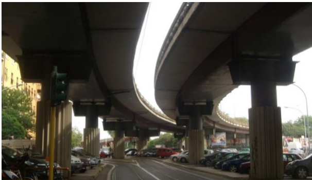
STRADA CONSOLARE – TANGENZIALE EST
